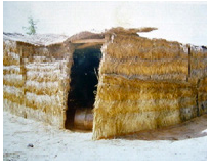
Ursprüngliches Unterrichtsgebäude aus Stroh in Karakara
