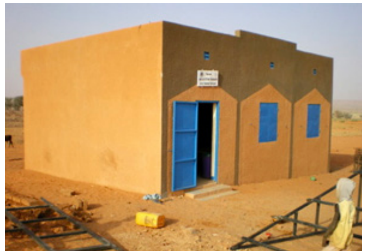
Neues, in Lehmbauweise errichtetes, Schulgebäude in Karakara – jede Klasse hat in Zukunft ein eigenes Gebäude
